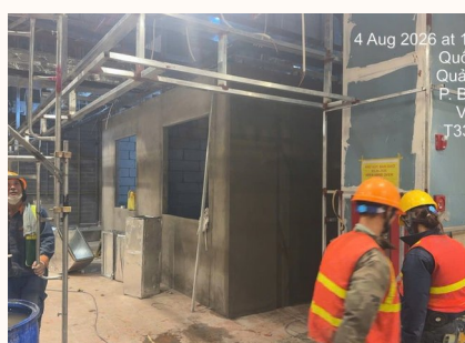
Mặt bằng thô vừa nhận trong trung tâm thương mại. Đội dựng khung trần, bắc giàn giáo, xây và trát vữa.
