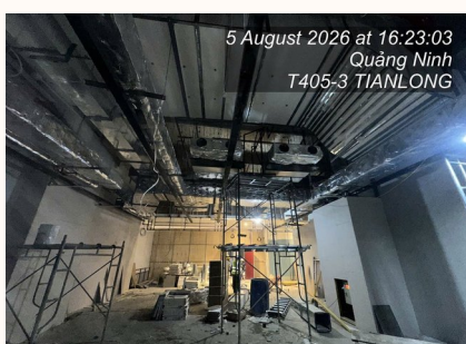
Mặt bằng thô vừa nhận trong trung tâm thương mại. Đội dựng khung trần, bắc giàn giáo, xây và trát vữa.
